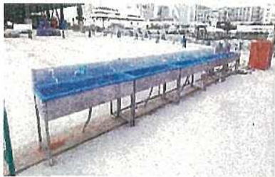
現場の手洗い場所の増設
