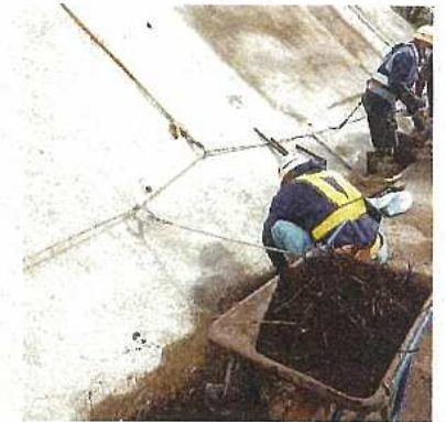
作業時なるべく離隔を確保
