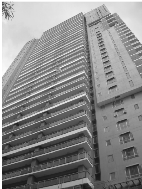
◀アヤラランドがフォートボニファシオで建設中の物件
