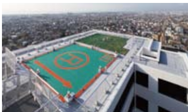
屋上ヘリポート
