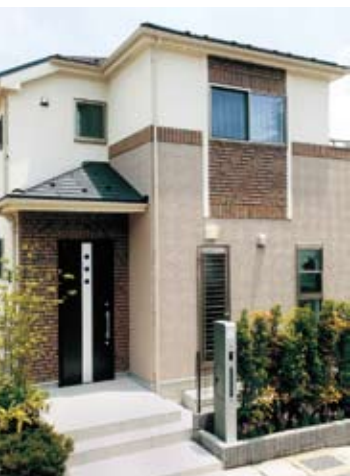
外観（11号棟西側）
