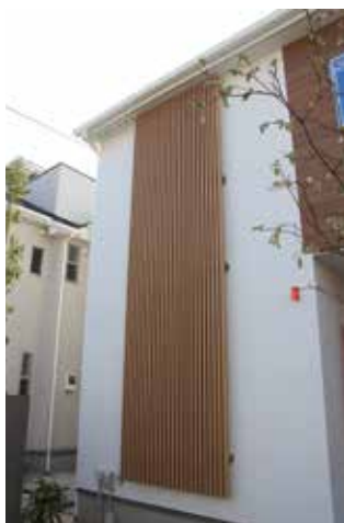
外壁ルーバーアクセント
