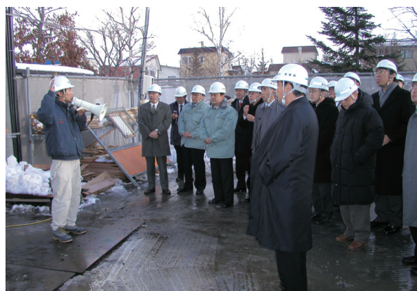
札幌ローコスト建築見学会 (12月、箱崎・マンション建設現場)
