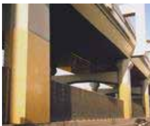
▲高速道路高架橋
