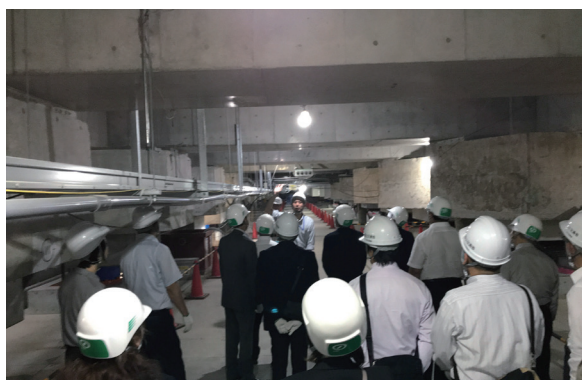
▲免震改修工事現場見学
