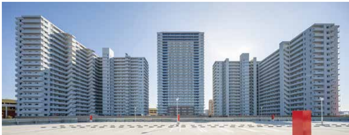
モントレー香椎浜サーフタワーセンターコート
