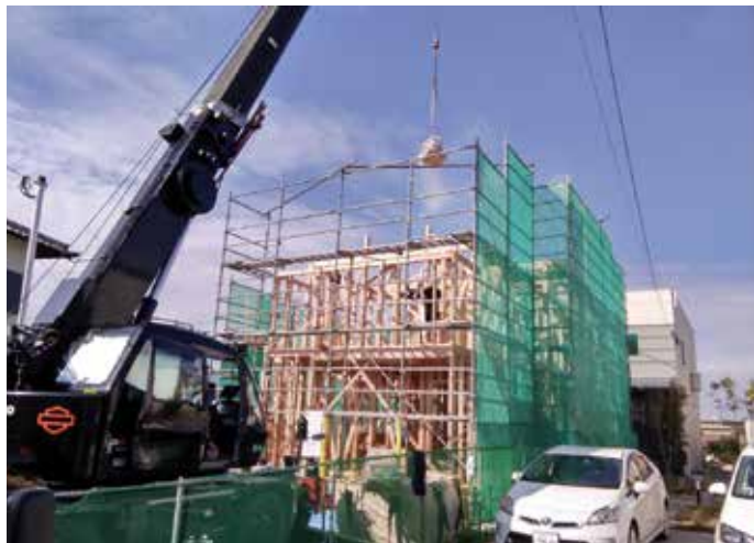
上棟 令和2年11月
